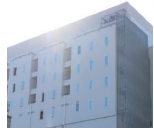
足場が解体された入院棟
