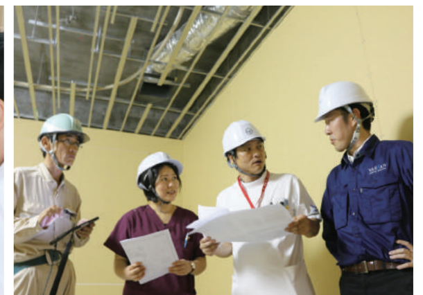
放射線治療装置設置に関する現地での打ち合わせ
