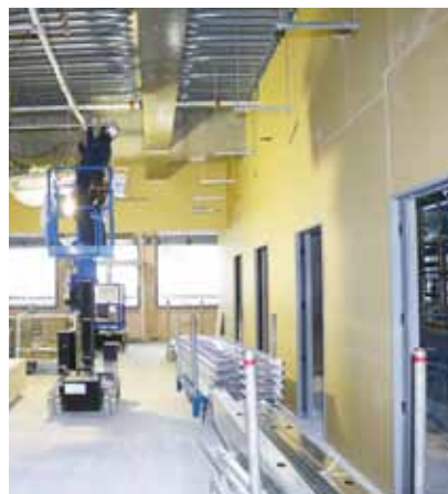
新外来棟の壁には診察室のドア枠が設置された
