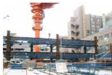
鉄骨建方の工事が進む新入院棟
