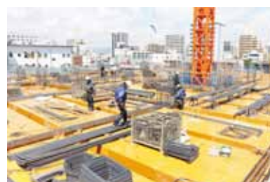
型枠が完成すると、次はコンクリート打設
