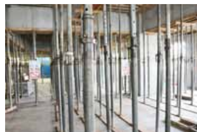
支保工が等間隔に並べられた新外来棟1階
